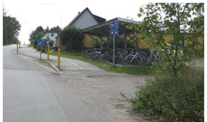
Pullerter ved cykelstien langs Hjarupvej ved Forbundsskolens sydlige ankomst.
